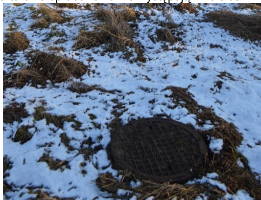
Fot.5. Jedna z wielu studzienek kanalizacji sanitarnej [źródło własne]
